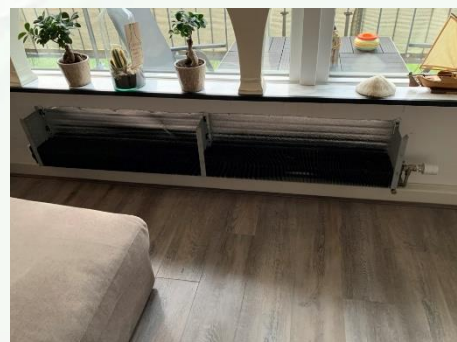
De convector zonder behuizing
